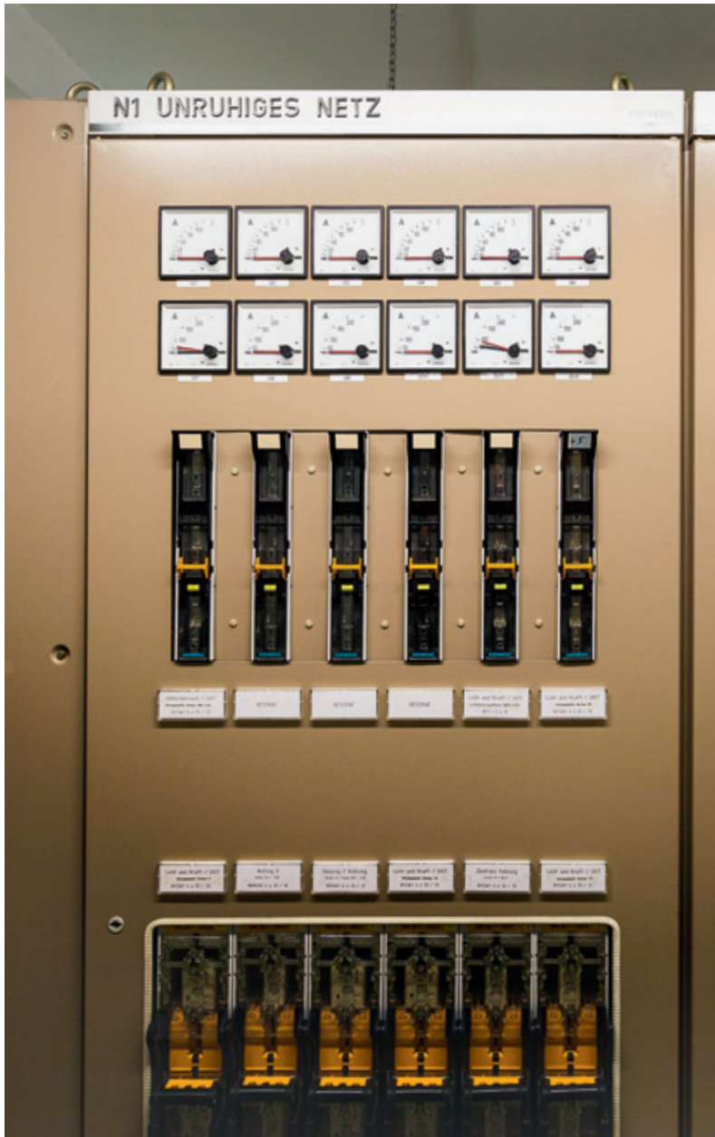
Überwachung Stromnetz, Konrad-Zuse-Zentrum für Informationstechnik Berlin
